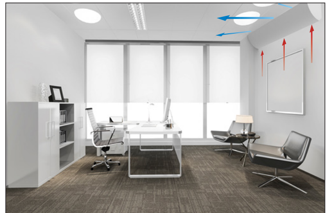
Abbildung 46. Plafond XD-FC mit Abdeckung Badge. Einbauprinzip "Wand an Kühlbalken".
