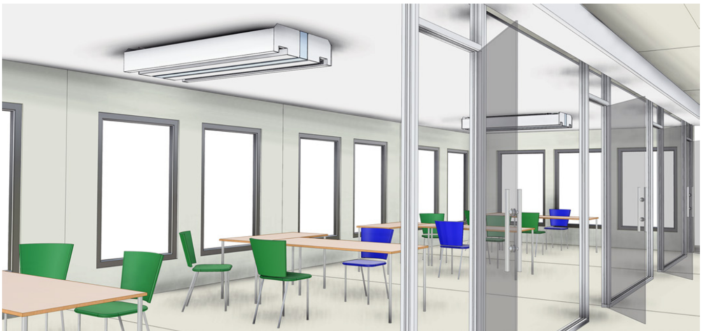
Abbildung 53. Die Trennwände wurden entfernt, ohne dass die Plafond Kühlbalken beeinträchtigt wurden.
