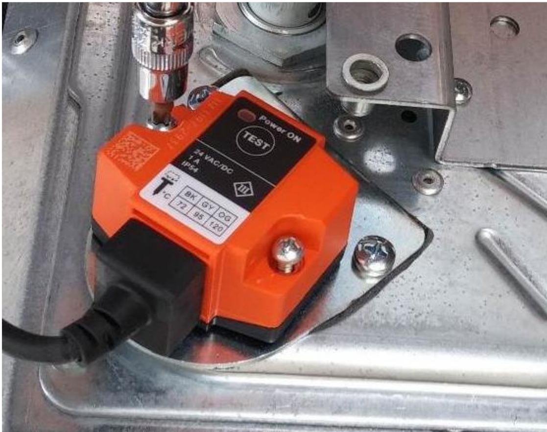
6.1.6. Stellen Sie sicher, dass das Brandschutzklappenblatt geschlossen ist und beachten Sie, dass auf der Vorderseite des Motors das Symbol „R“ von außen sichtbar sein muss.
