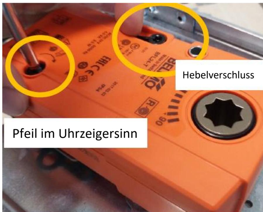
Befestigen Sie die 2 M6x60mm-Schrauben mit dem Inbusschlüssel M6, um den Stellantrieb zu fixieren.
