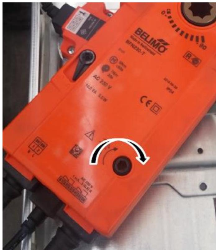
6.1.9. Drehen Sie den auf dem Foto angegebenen Hebel, um den Motor und das Brandschutzklappenblatt in die gewünschte Position zu bringen.
