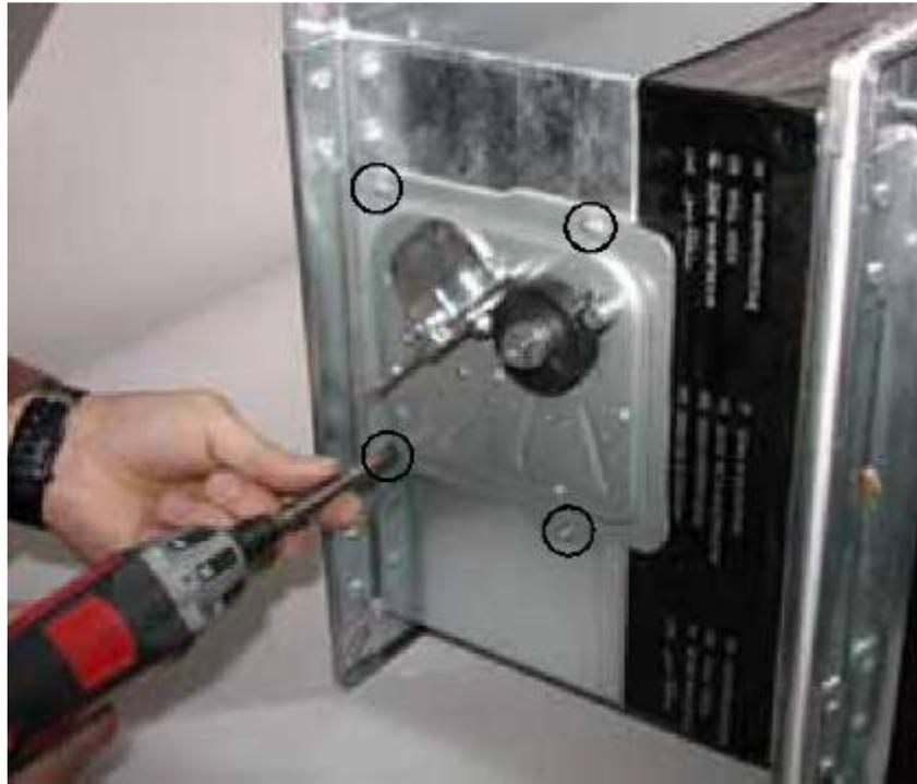
6.1.2. Entfernen Sie die Antriebseinheit von der Brandschutzklappe
