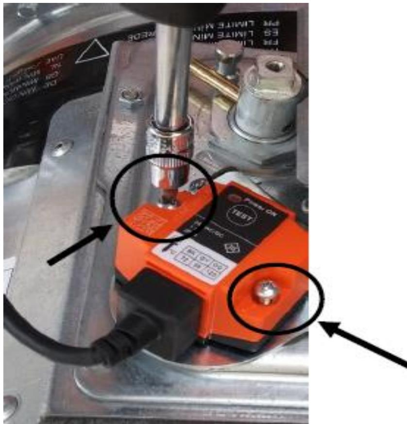
7.1.7. Stellen Sie sicher, dass das Brandschutzklappenblatt geschlossen ist und beachten Sie, dass auf der Vorderseite des Motors das Symbol „R“ von außen sichtbar sein muss.
