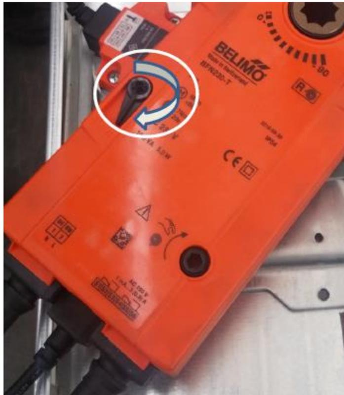
6.1.10. Befestigen Sie den Motor mit Hilfe der beiden Schrauben und entriegeln Sie den Motor.
