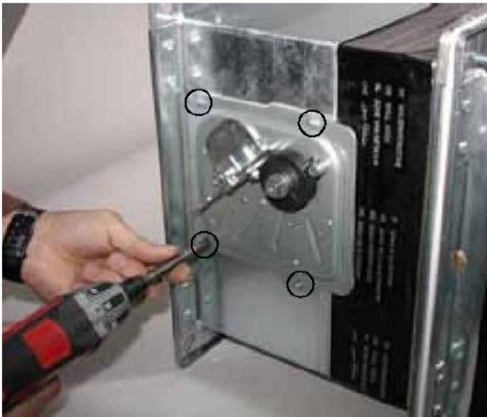
7.1.3. Montieren Sie die neue Montageplatte WK45MTB und befestigen Sie diese mit den 4 Schrauben.
