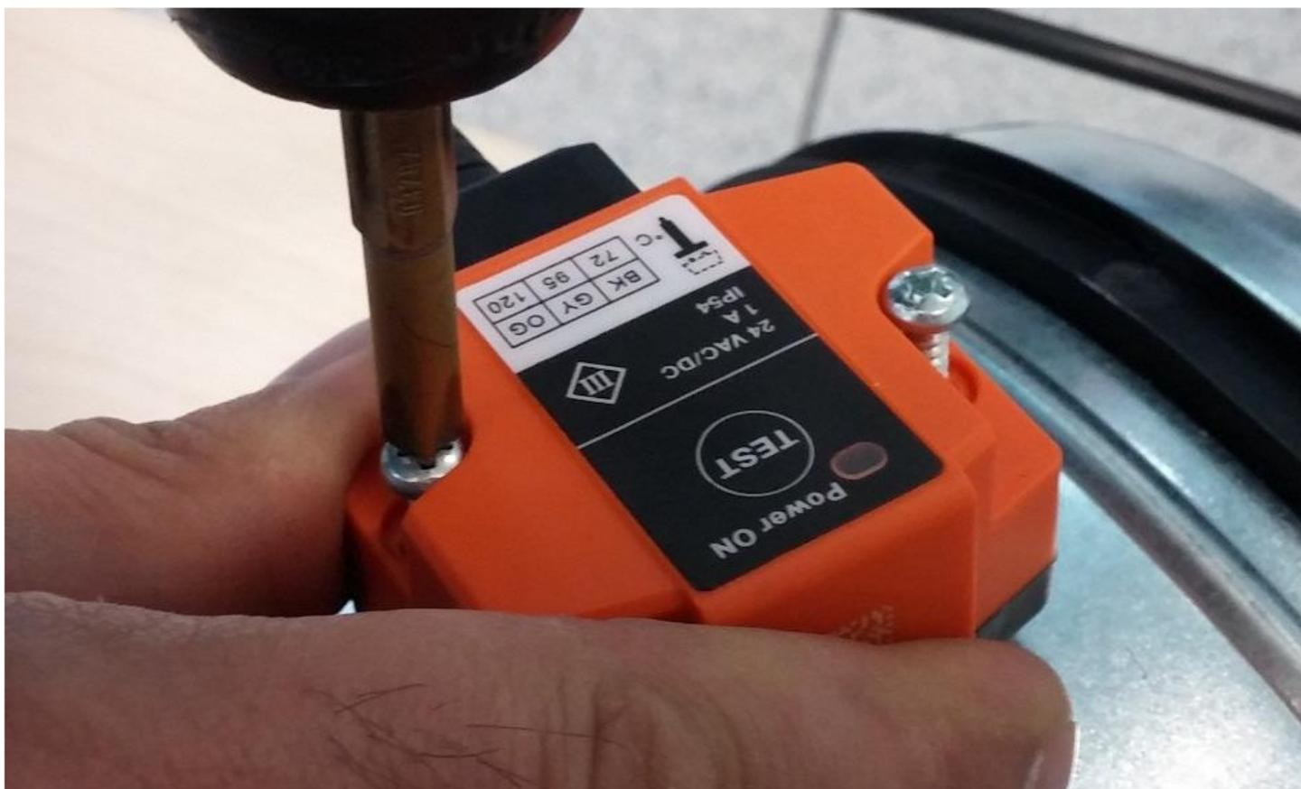
Wenden Sie den Positionsanzeigepfeil an und führen Sie einen manuellen Öffnungs- / Schließtest durch. Überprüfen Sie die Rückmeldung der Motor-Mikroschalter (Endlagenschalter) mit einem Multimeter, während sich das Klappenblatt von der geöffneten in die geschlossene Position bewegt.
