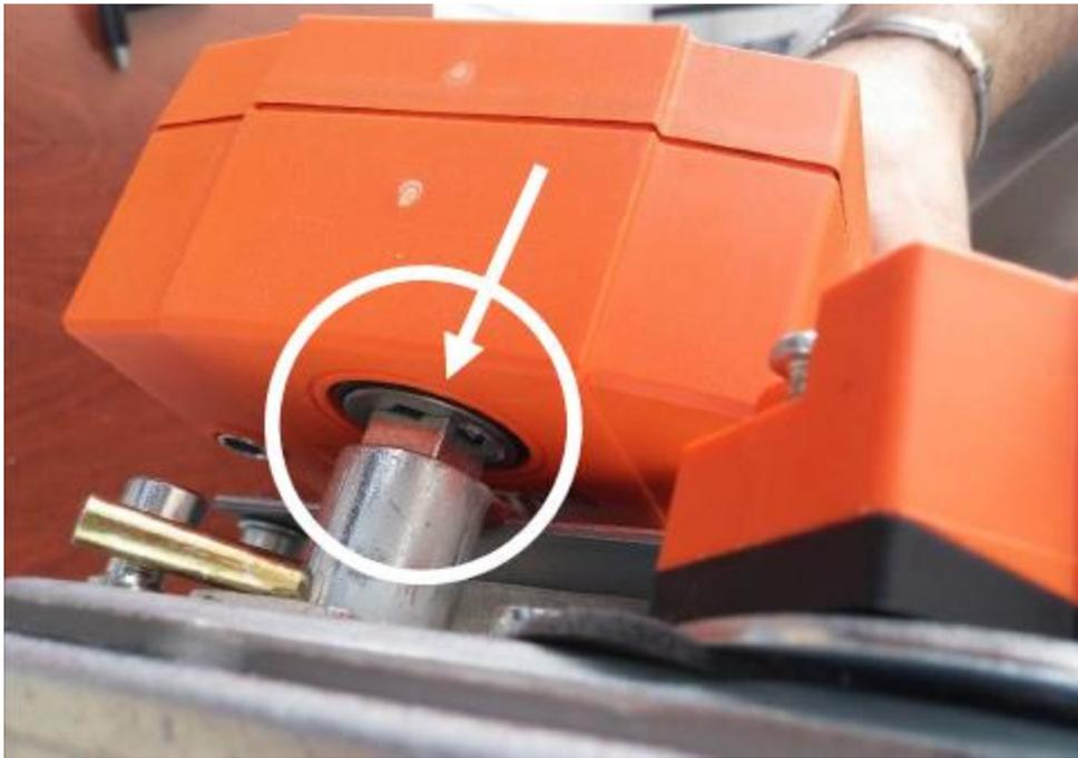
6.1.8. Zum Ausrichten der Motorschraubenlöcher mit der Konsole der Brandschutzklappe, können Sie bei Bedarf den mit dem Motor gelieferten Griff verwenden und diesen vorsichtig im Uhrzeigersinn drehen. (siehe Pfeil in der Abbildung).
